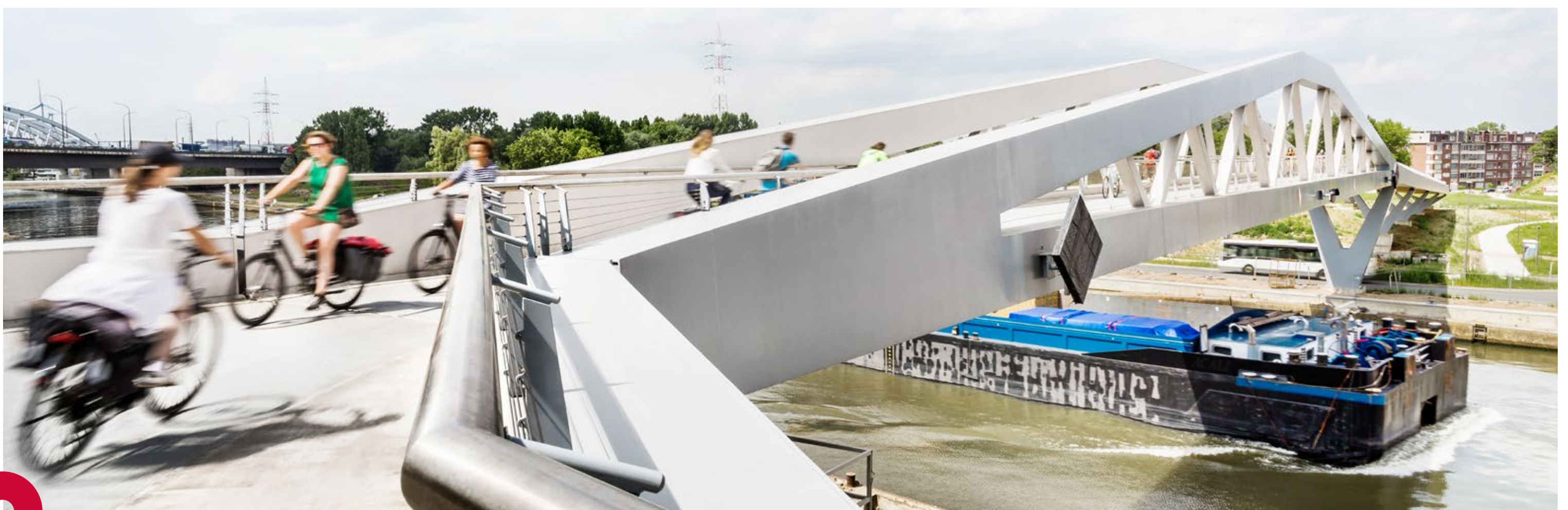
BOVEN IJzerlaankanaal — ONDER Fietsbrug IJzerlaan
