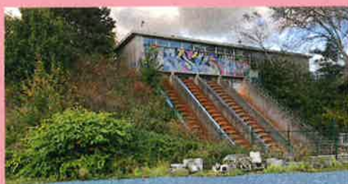
Zicht op het pompgebouw met zijn Archimedesschroeven
